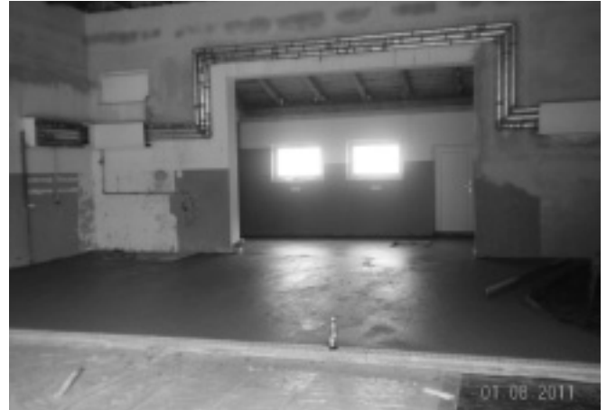
Die neue Abwasserrinne mit frischem Estrich
