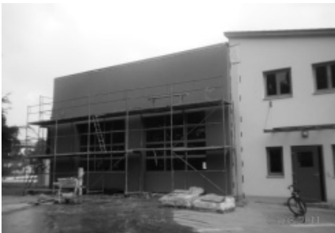
Die neue Fassade ist bereits verputzt.
