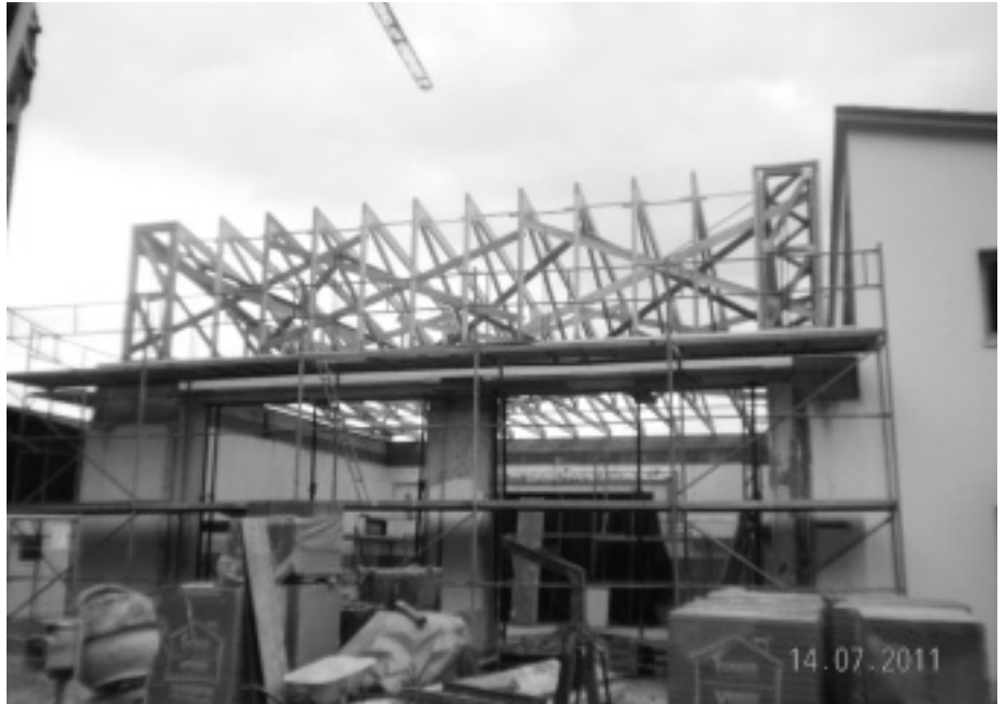
Der neu errichtete Dachstuhl am Feuerwehrgerätehaus Steinach
