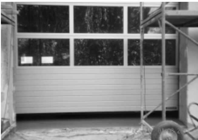
Die neuen automatischen Rolltore
