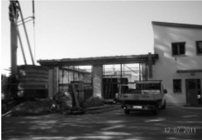
Die Fahrzeughalle komplett ohne Dachstuhl
