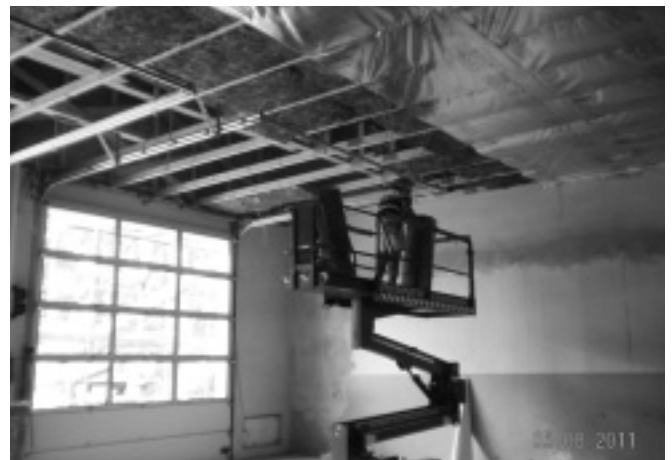
Der Trockenbau macht Fortschritte.
