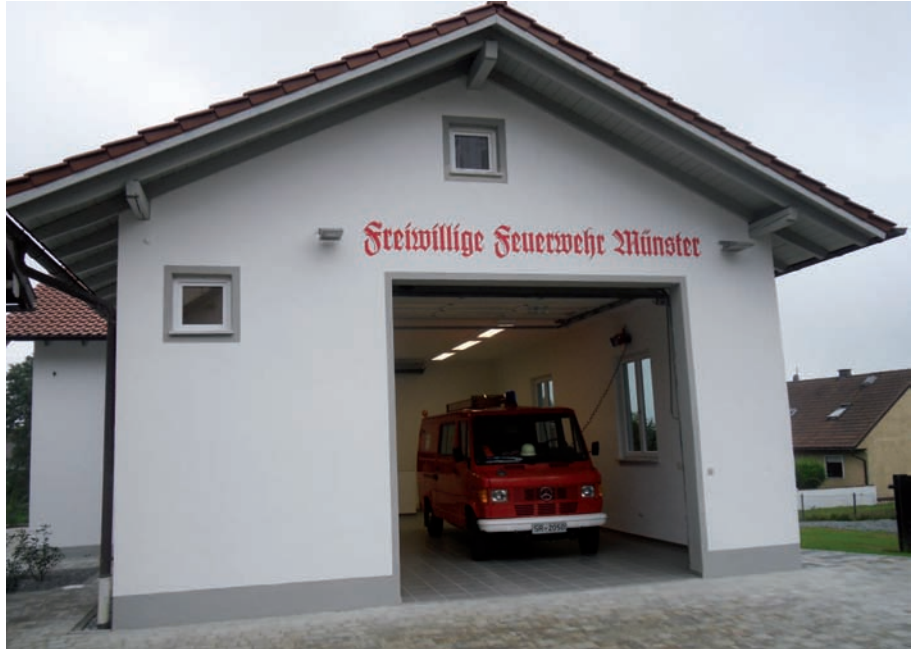
Süd-West-Ansicht des Anbau
