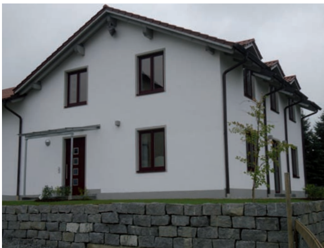
Süd-West-Ansicht vom Anbau
