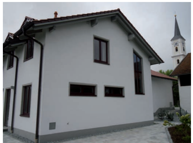
Ostseite des Anbaus
