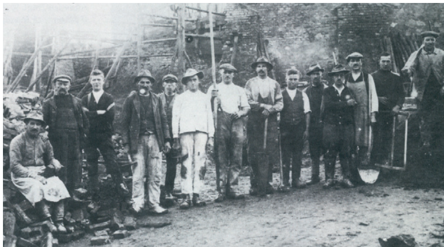
Arbeitsgruppe beim Wiederaufbau der Friedhofmauer 1926
