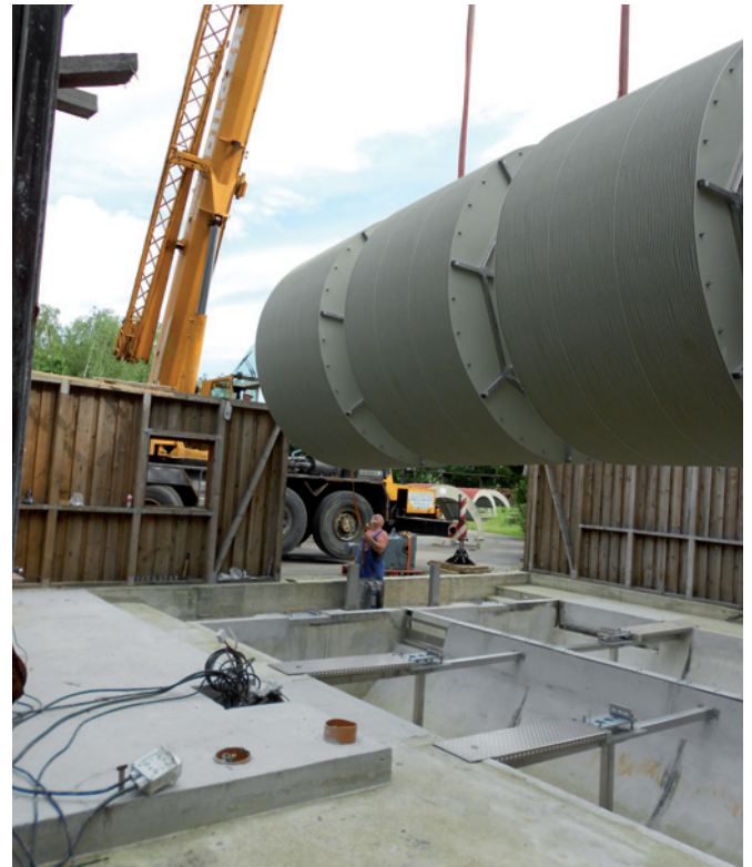
Einsetzen eines neuen Scheibentauchkörpers
