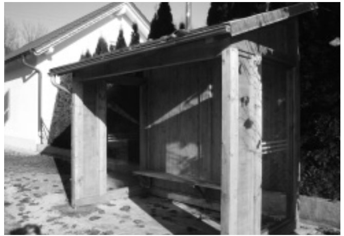
Das Buswartehäuschen wurde bereits aufgestellt.
