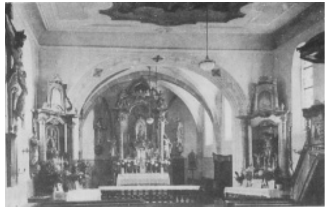
Die Steinacher Kirche vor dem Umbau von 1955/1956
