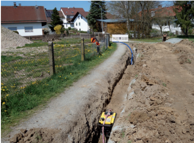
Beim Fußweg am Sportzentrum hatten die Bauarbeiter noch genügend Platz um die Leitung zu verlegen
